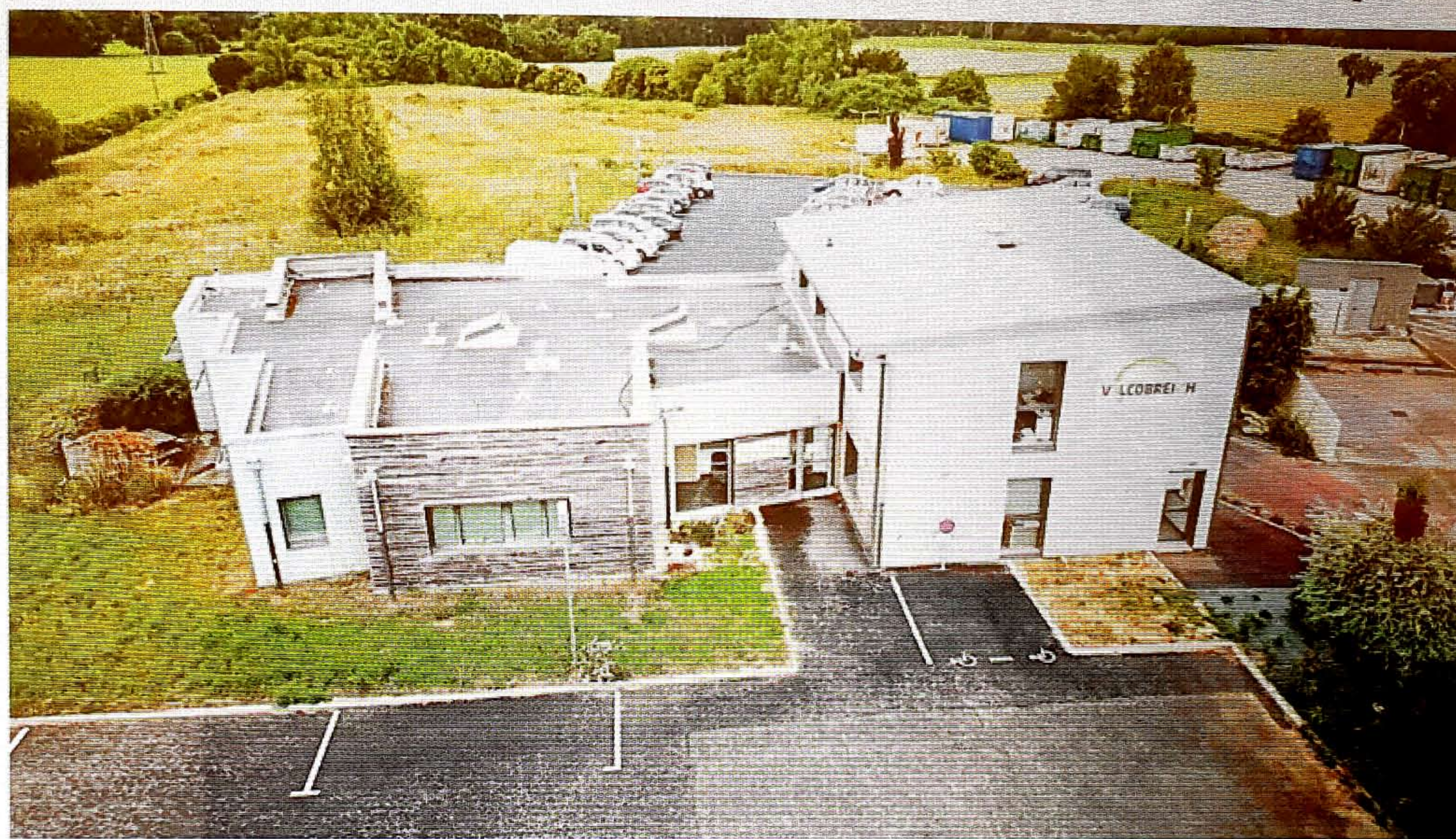
Le champ solaire se trouvera derrière le bâtiment du Smitcom Valcobreizh. Les travaux seront réalisés courant 2025. PHOTO: VALCOBREIZH
